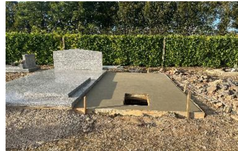
3ème ossuaire pour une utilisation éventuelle ultérieure
